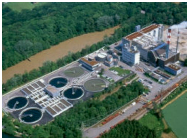
Fig. 3 Rentable Einsparungen von 44% beim Zweckverband Abwasserregion Solothurn - Emme durch gezielte Energieoptimierung an Pumpen im Kanal
