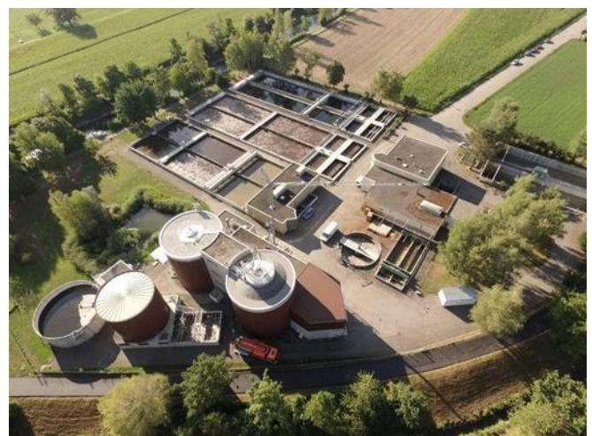
Gasdichte Abdeckung des Schlammstapelbehälters am Beispiel der ARA Niederglatt (Foto: South Pole)
