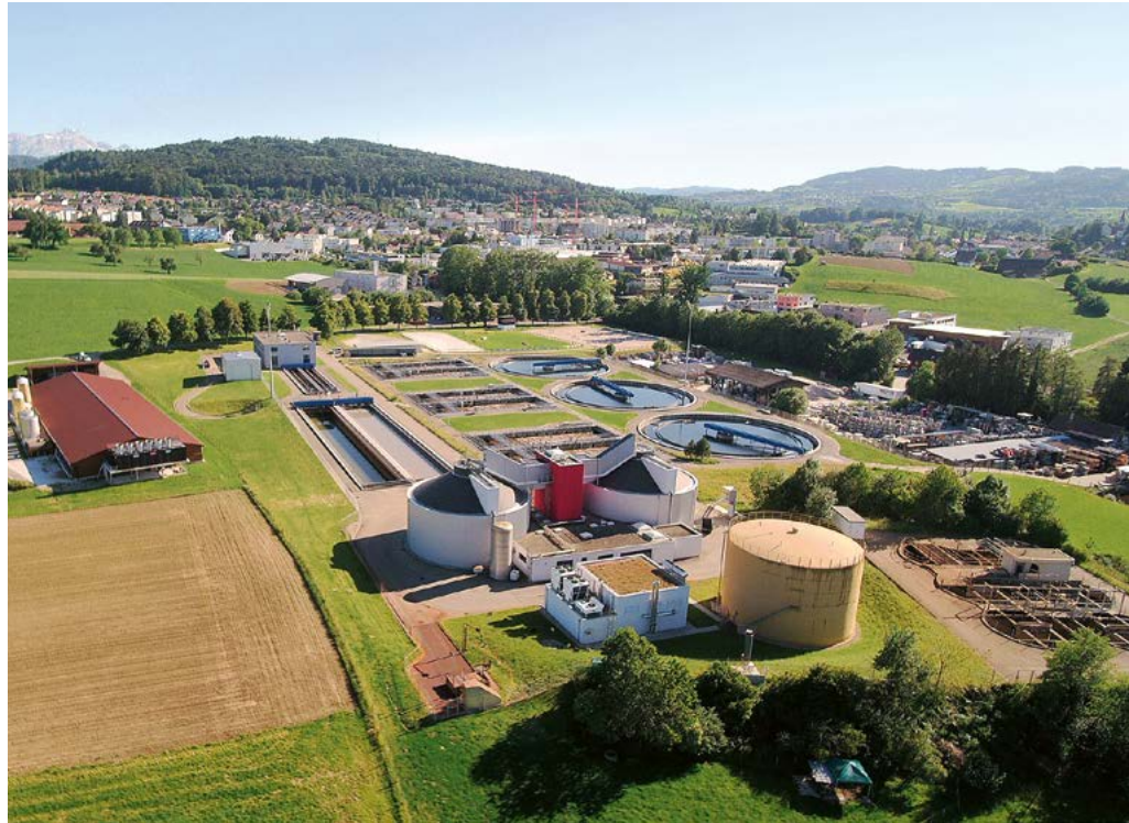
Die Kläranlage Hofen in St. Gallen mutiert vom Energiebezügler zum Energielieferanten.
